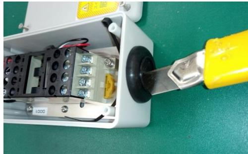
5. 黒いカバーを外し、集塵スイッチ端子のネジ(10)番、(14)番を緩めて集塵機の連動スイッチコードを取り付けます。
